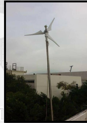
Fig. 4. Ensamble y puesta en marcha del Generador Eólico
